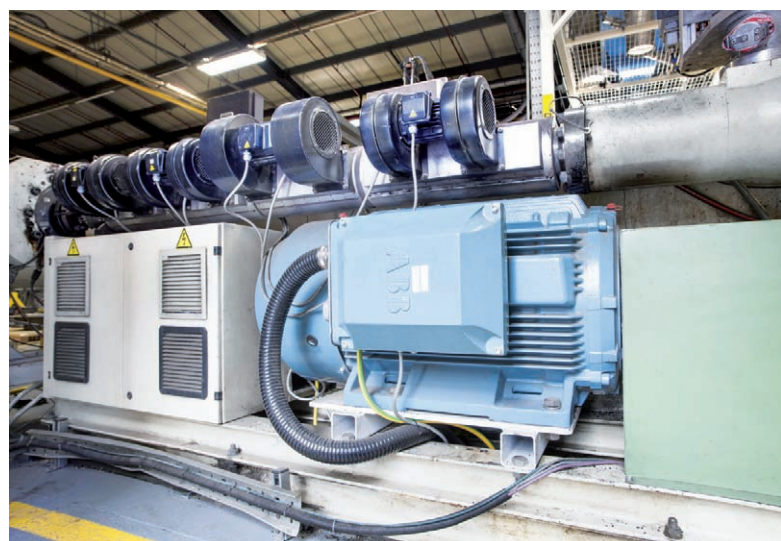
Pohon so SynRM inštalovaný u zákazníka nahradil zastaraný DC motor.
